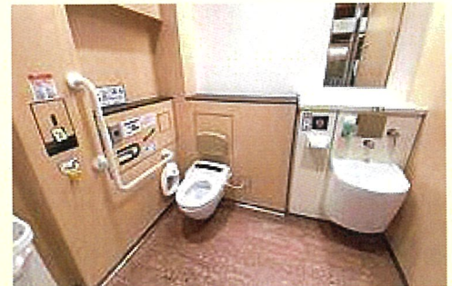
オストメイト対応設備
